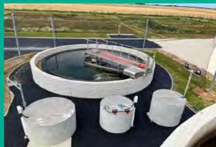
Mise en service de la 1ère file de la station d'épuration, de 500 équivalents habitants, à Montereau-sur-le-Jard
