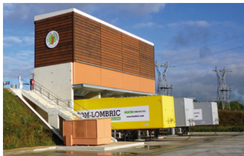
/ le quai de transfert de Réau et les bennes FMA /
