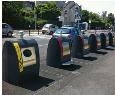
/ bornes enterrées installées au Mée-sur-Seine. Au total, la Communauté d'Agglomération Melun Val de Seine compte 319 bornes sur son territoire /
