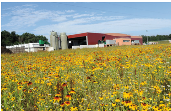
/ la plateforme de compostage de Réau /
