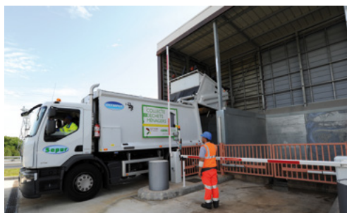
/ le quai haut : lieu de déchargement des camions de collecte /
