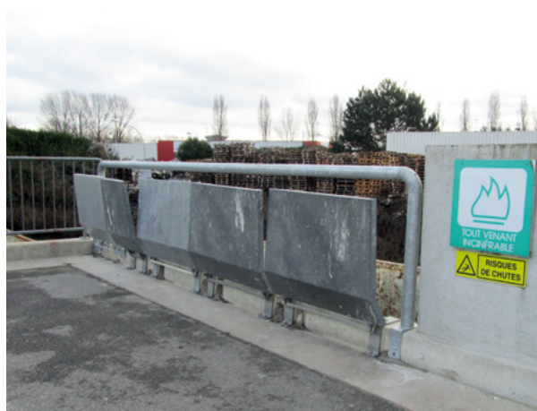
/ Le dispositif antichute sur la déchèterie de Savigny-le-Temple /
